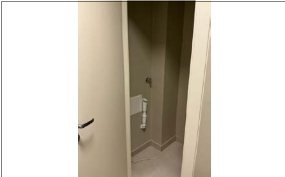
Kott med opplegg for vaskemaskin.
