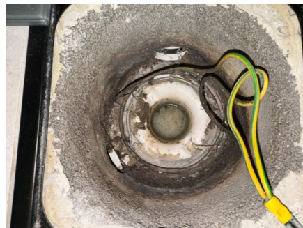
Plastsluk med klemring og synlig membran
