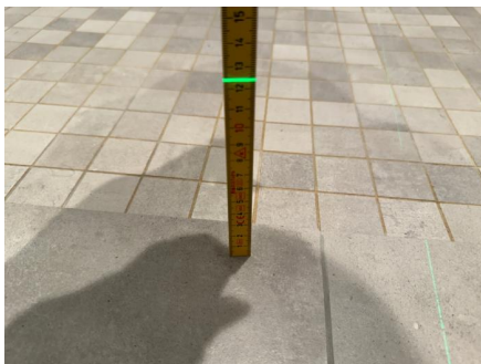
Fallforhold ca. 125 mm overkant gulv ved dusjsone
