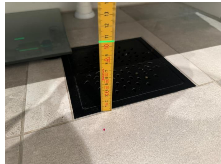
Fallforhold ca. 105 mm topp slukrist ved servant
