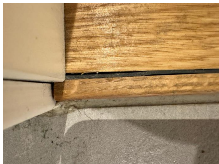
Synlig membran oppbrett ved terskel
