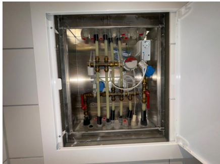
Vannfordelerskap rør-i-rør system, waterguard og stoppekran
