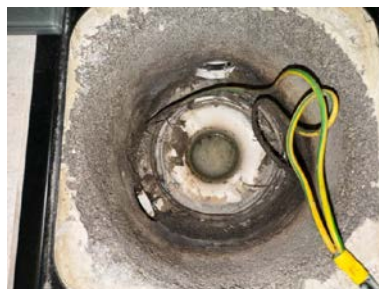
Plastsluk med klemring og synlig membran
