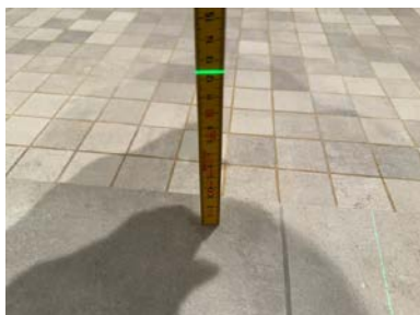
Fallforhold ca. 125 mm overkant gulv ved dusjsone
