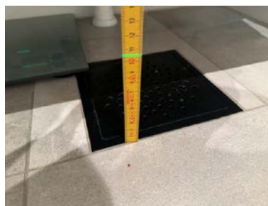
Fallforhold ca. 105 mm topp slukrist ved servant
