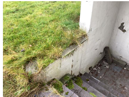
Rekkverk mangler.
