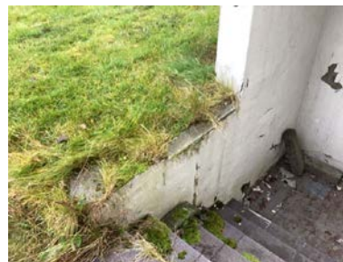
Rekkverk mangler.
