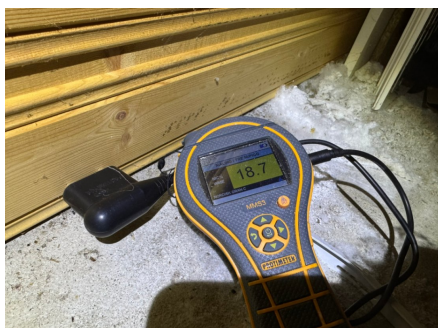
Fuktmåling i trepanel.
