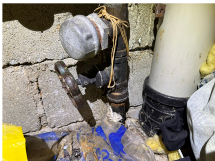
Stoppekran spindelventil.
