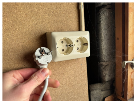
Berederen er ikke fast tilkoblet.
