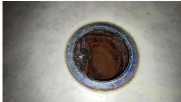
Kontroll av sluk.
