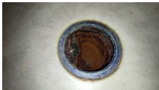
Kontroll av sluk.
