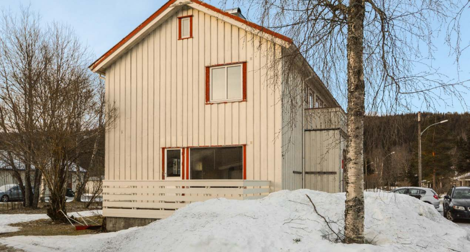
Fasade og terrasse
