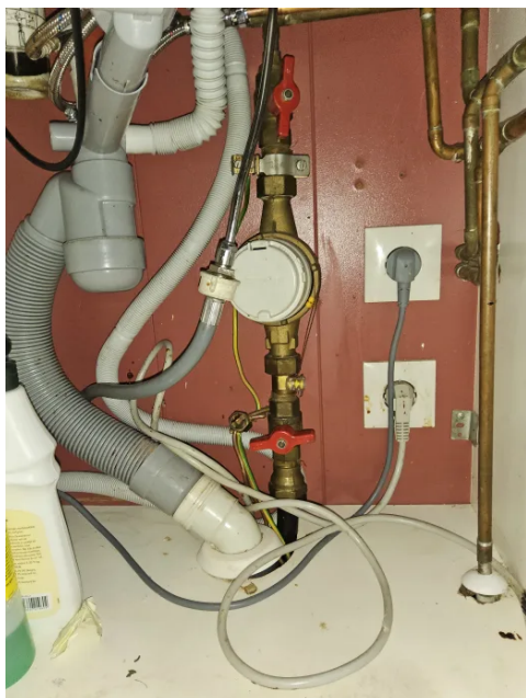
Bilde viser hovedstoppekran.
