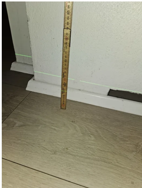
Bilde viser måling av etasjeskiller.
