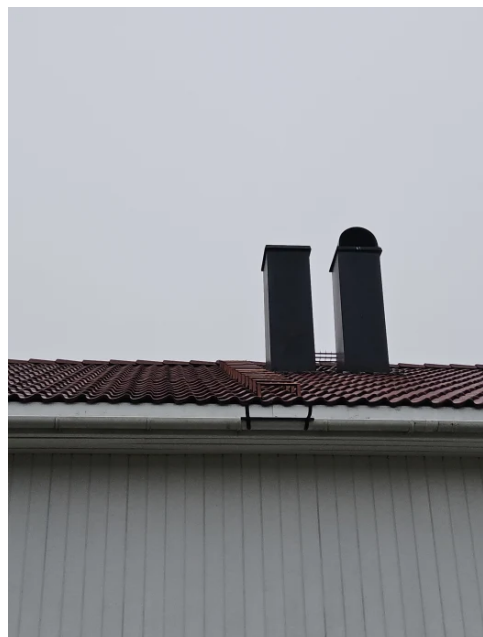
Bilde viser takstige.
