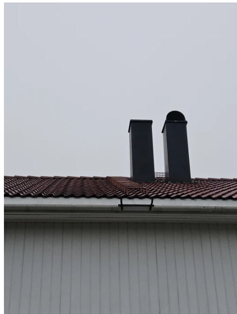
Bilde viser taktekking.
