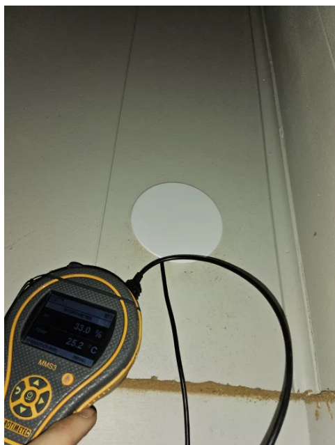
Bilde viser fuktmåling.
