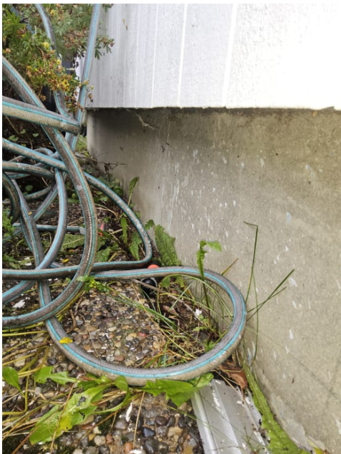
Bilde viser deler av grunnmur.
