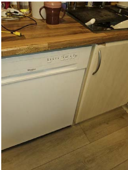
Bilde viser skader på kjøkkeninnredningen.
