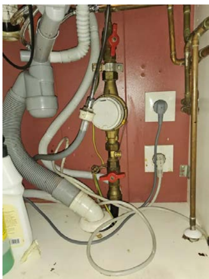
Bilde viser hovedstoppekran.
