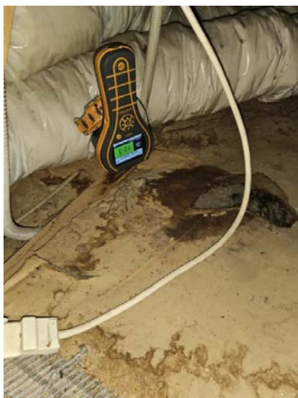
Bilde viser fuktmåling på kaldtloft.
