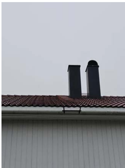
Bilde viser taktekking.
