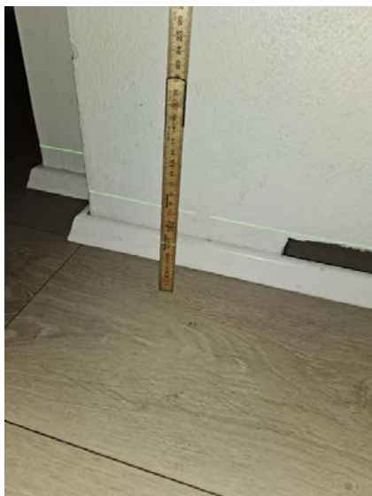
Bilde viser måling av etasjeskiller.
