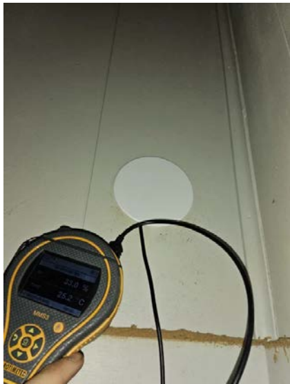
Bilde viser fuktmåling.
