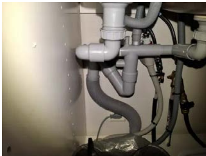
Synlige avløpsrør av plast.
