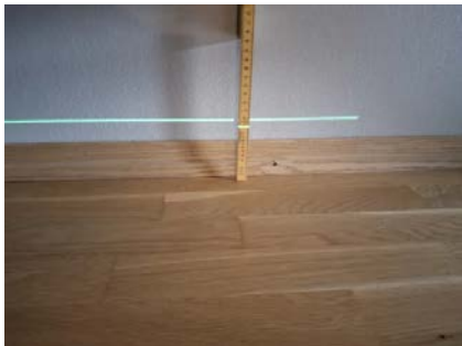
Etasjeskillet er kontrollert med nivelleringslaser.
