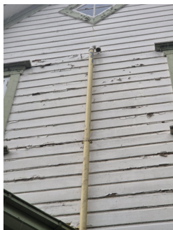
Kledningsbord mot vest bærer preg av slitasje.
