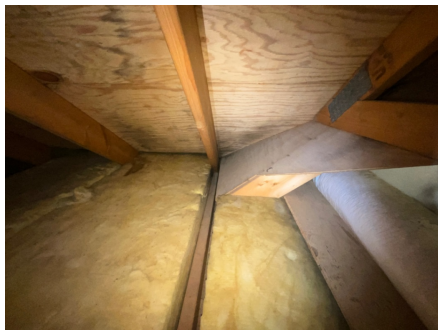
Utettheter i dampspærren.
