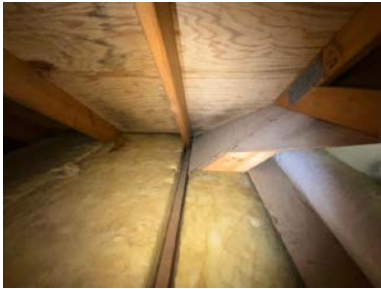
Utettheter i dampsperran.
