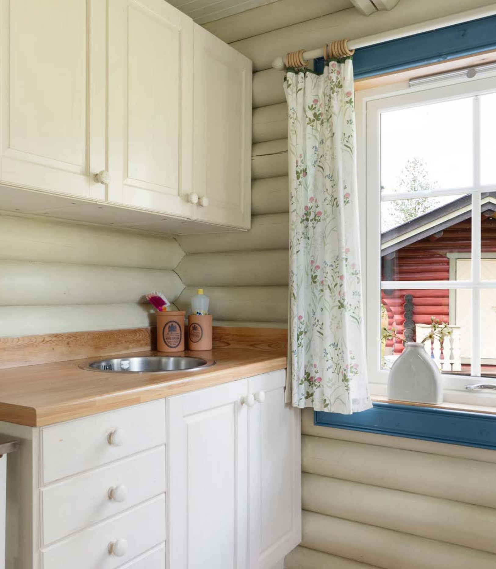
Avløp fra kjøkkenbenk til terreng.
