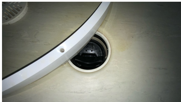
Kontroll av sluk.
