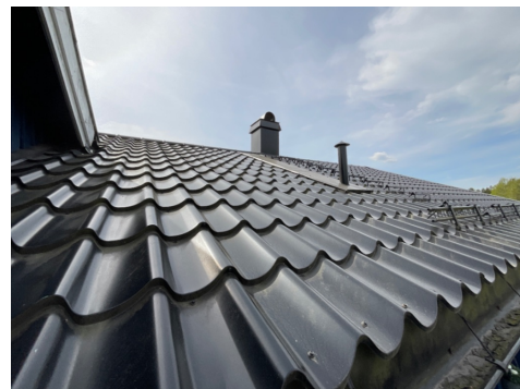
Taktekking med metallplater
