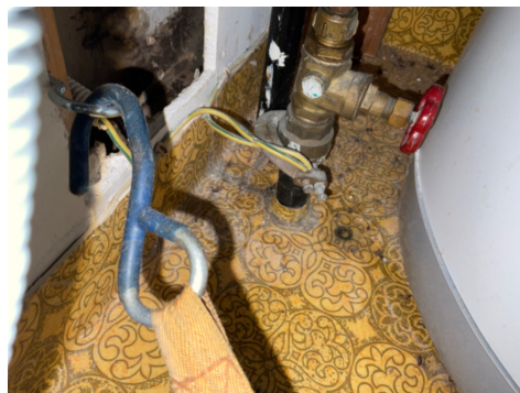
Synlig plast ledning opp av kjellergulv til stoppekran
