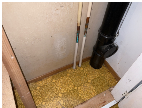
Avløpsrør av plast ned i kjellergulv
