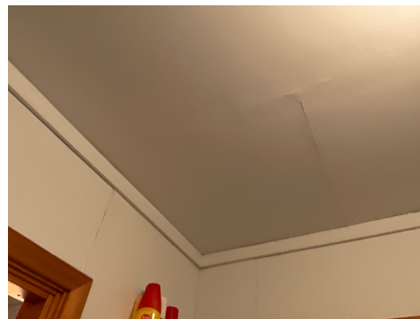
Takoverflate i kjelleren
