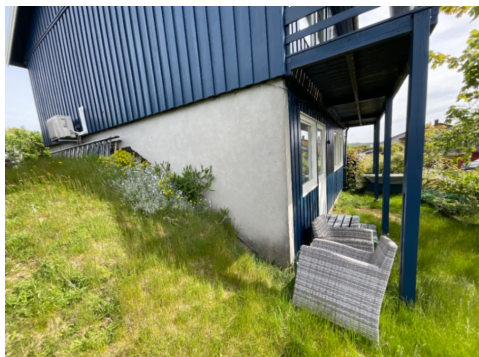
Grunnmuren sett fra hagen
