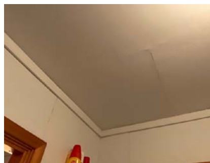
Takoverflate i kjelleren
