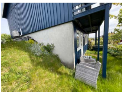
Grunnmuren sett fra hagen
