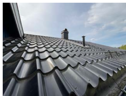
Taktekking med metallplater
