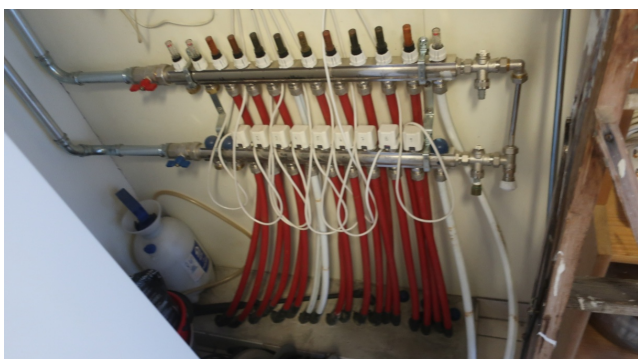
Rørfordeling - gulvvarme.
