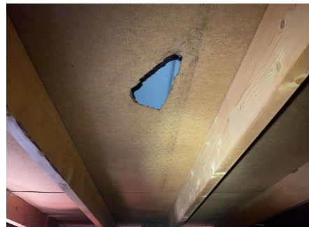
Hull på undertaksplate.
