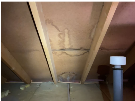
Fuktskjolder på undertaket flere steder. Det er uklart om fuktmerkene skyldes tidligere eller nylig vanninntrengning. Merker var tørre ved befaring.
