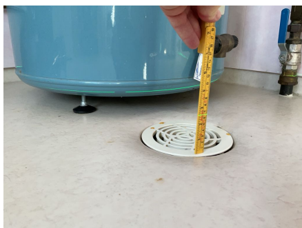
Målt fall til sluk: 14mm.
