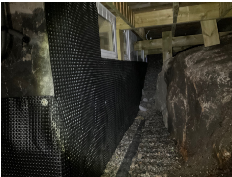
Synlig grunnmursplast under terrasse
