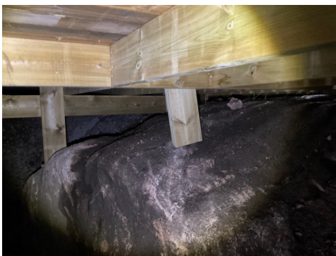
Understøtter av tremateriale på terreng
