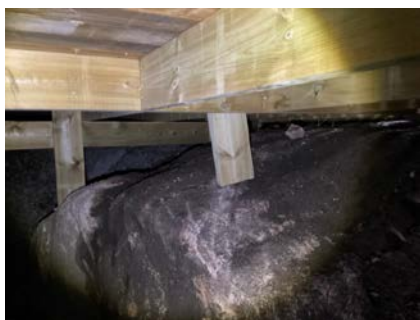
Understøtter av trematerialie på terreng
