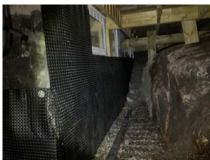
Synlig grunnmursplast under terrasse
