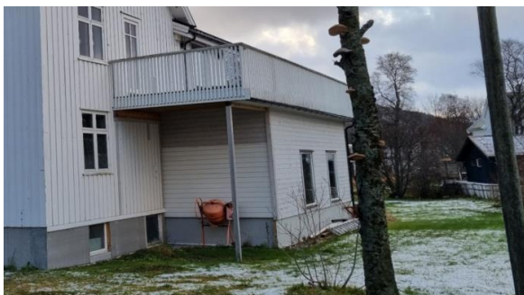
Altan ligger delvis over innredet garasje.
