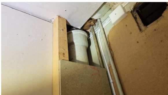
Det er avløpsrør av soil fra bad i loftetasjen.
