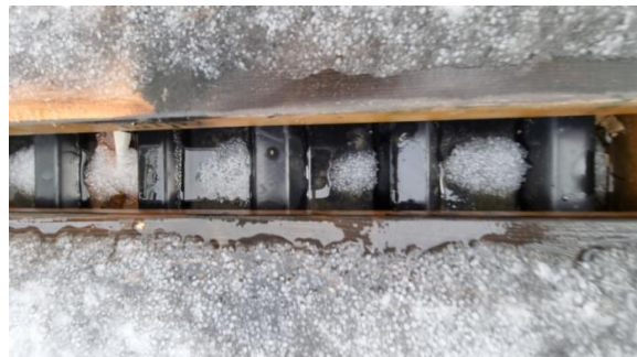
Det er tettesjikt/membran av A-profilerte takplater med underliggende tettesjikt av takpapp.
