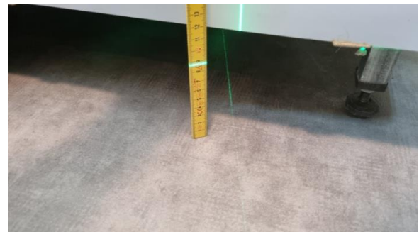
Kontroll av fall til sluk.
