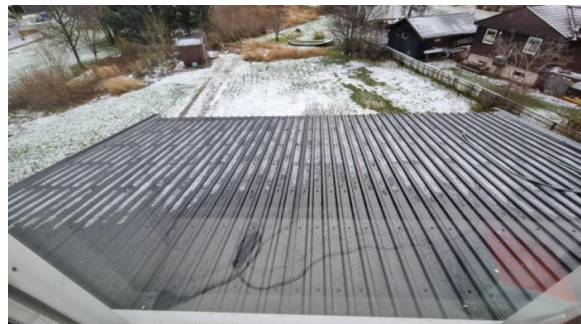
A-plater på tilbygget trappehus.
