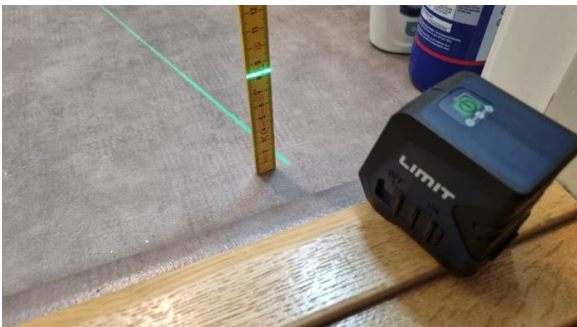
Kontroll av fall til sluk.
