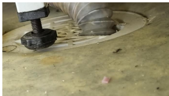
Plastsluk med synlig vinylbelegg som membran.
