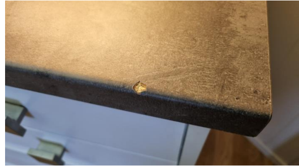
Sår/hakk i benkeplate.
