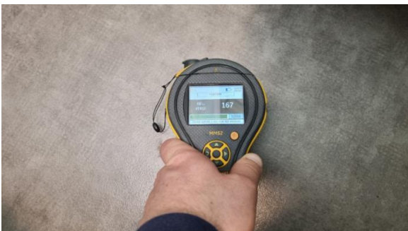
Det ble fuktmålt ved befaring, ingen unormale verdier ble registrert.
