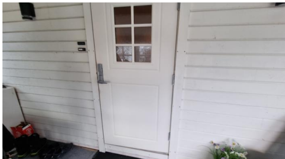
Inngangsdør fra 2012 montert i 2016.
