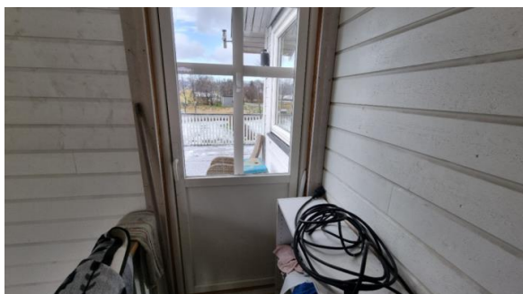
Terrassedør mellom trappeoppgang og takterrasse.
