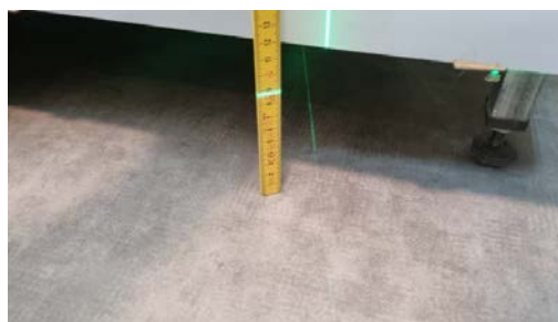
Kontroll av fall til sluk.
