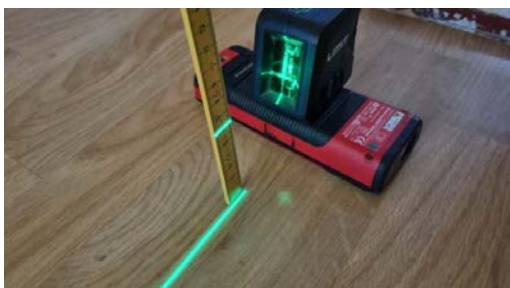
Kontroll av planavvik.
