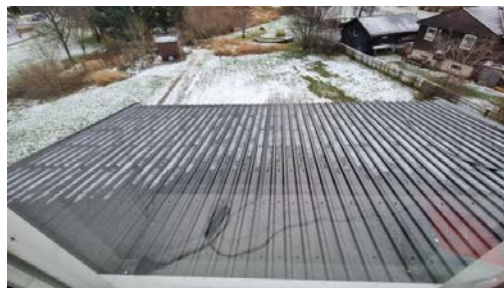
A-plater på tilbygget trappehus.
