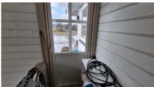
Terrassedør mellom trappeoppgang og takterrasse.
