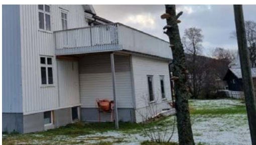
Altan ligger delvis over innredet garasje.
