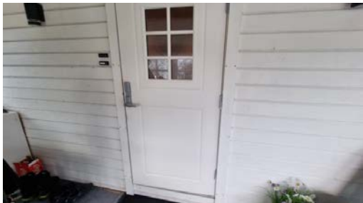
Inngangsdør fra 2012 monterert i 2016.
