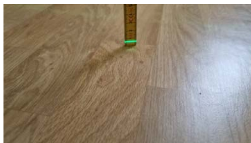
Kontroll av planavvik.
