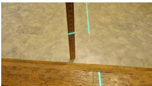
Kontroll av fall.
