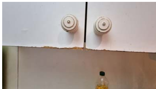
Innredningen har slitasjer.
