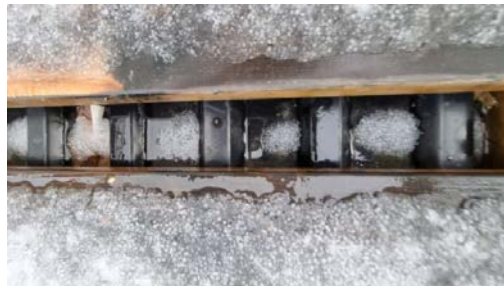
Det er tettesjikt/membran av A-profilerte takplater med underliggende tettesjikt av takpapp.
