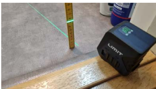
Kontroll av fall til sluk.
