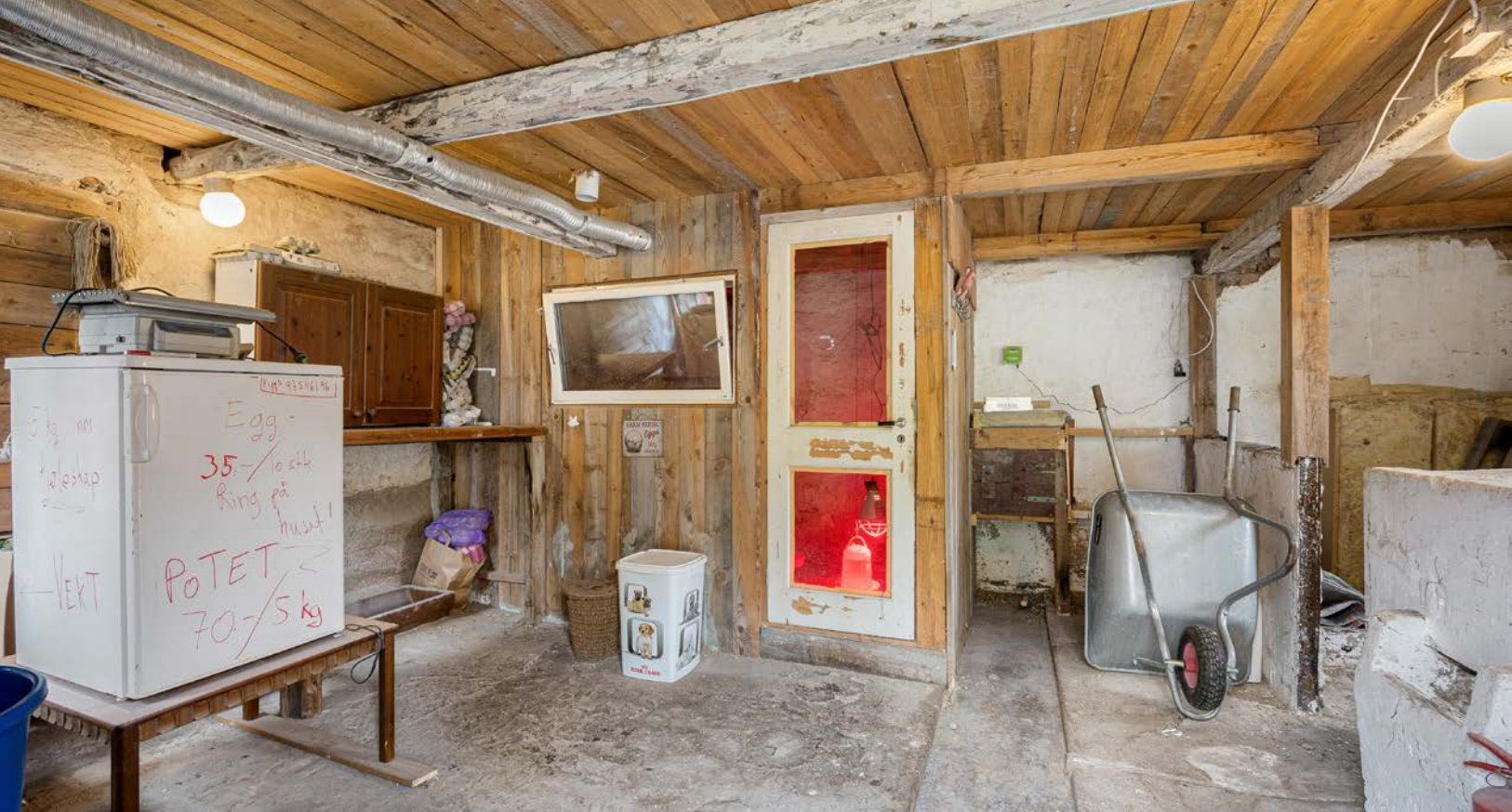
I første etasjen av låven er det fjøs, garasje, bod og trimrom.
