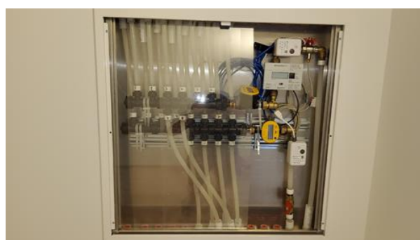
Tekniske anlegg, VVS anlegg (Sjekkpunkter utover det som er inkludert i andre rom) - [Fordelerskap for rør-i-rør-systemet]
