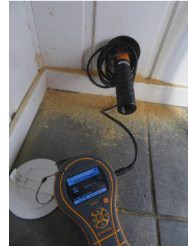
Fuktsøk fukt - Naturlige utslag - ingen forhøyede fuktverdier.
