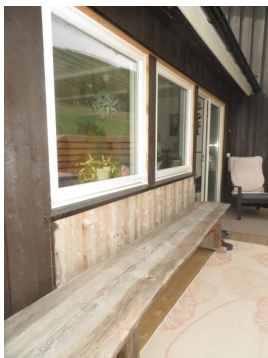
Nye vinduer samt ny terrassedør i spisestue ut mot veranda.
