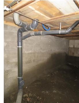
Del av vann og avløpsrørene - åpent anlegg - ingen påviste avvik.
