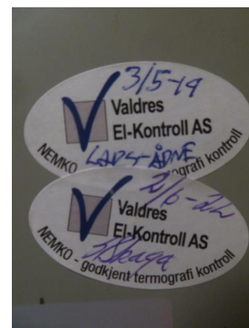
Valdres EI-Kontroll - datert 2/6-22.
