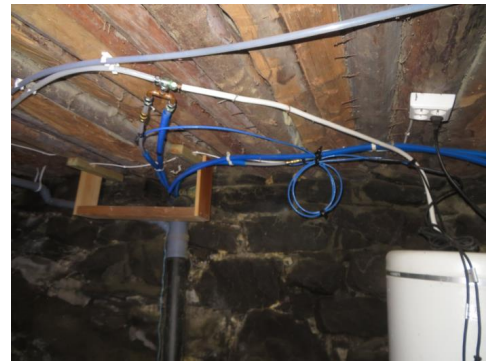
Åpent opplegg av vannledninger i jordkjeller.
