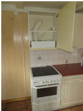
Avtrekkventilering ført ut gjennom vegg.
