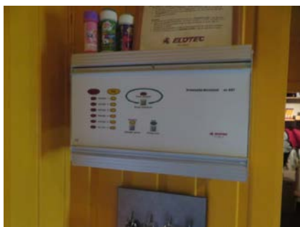
Varslingsentral for overvåkning i driftsbygning.
