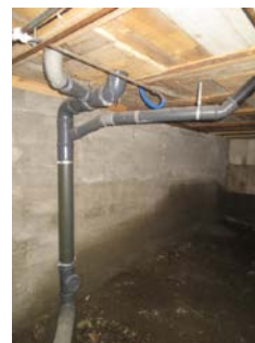
Del av vann og avløpsrørene - åpent anlegg - ingen påviste avvik.
