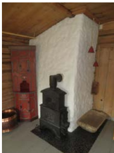
Støpejernsinnsett med murt og pusset omramming i 1.etg.
