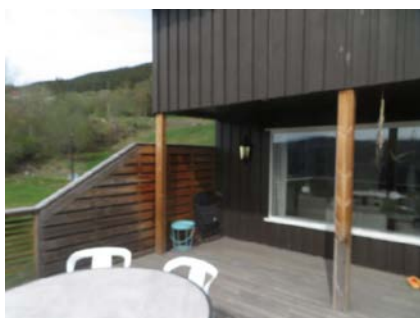
Veranda ut for stue.
