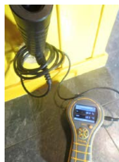
Fuktsøk relativ fuktighet - Naturlige utslag - ingen forhøyede fuktverdier.
