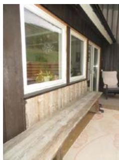
Nye vinduer samt ny terrassedør i spisetue ut mot veranda.
