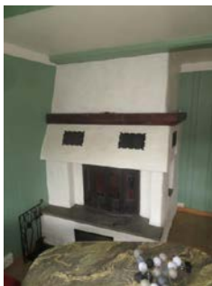
Støpejernsinnsett med murt og pusset omramming i 1.etg.
