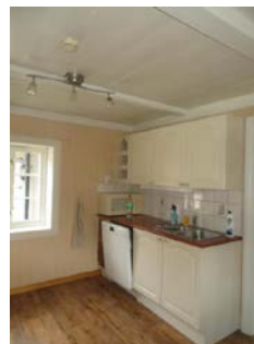
Del av kjøkken - vaskebeslag og oppvaskmaskin.
