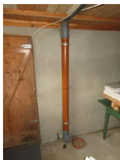
Del av avløpsrørene - stakeluke er montert.
