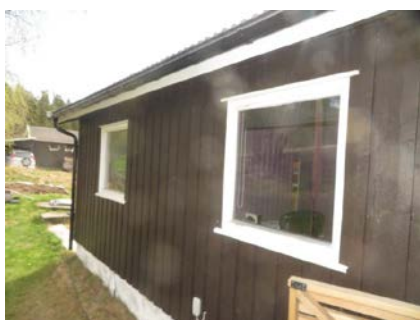
Eldre vindu på kontor.
