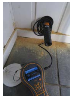
Fuktsøk fukt - Naturlige utslag - ingen forhøyede fuktverdier.
