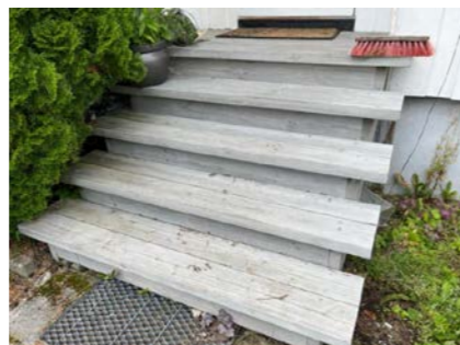
Manglende rekkverk.
