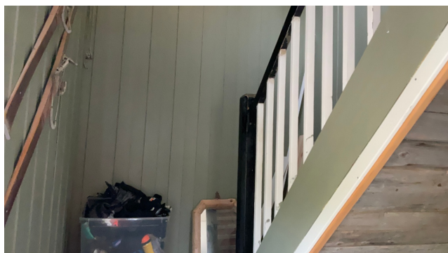
Trapp mellom 1. og 2.etasje.
