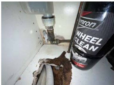
Lekkasje fra rør i kjøkkenbenk.
