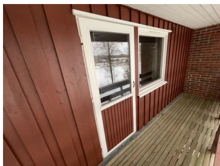
Balkongdør i soverom
