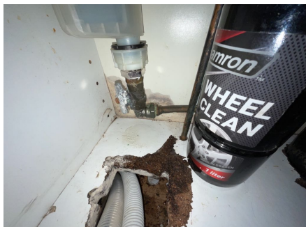
Lekkasje fra rør i kjøkkenbenk.
