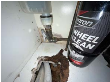
Lekkasje fra rør i kjøkkenbenk.
