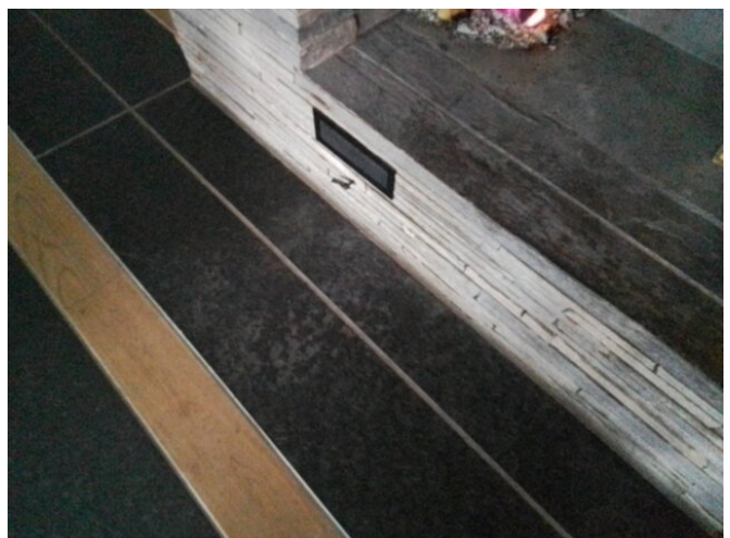
flekker på gulv skifer etter slukking
