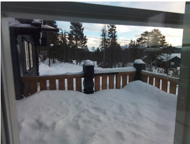
Behov for vask av vinduer etter pipebrann
