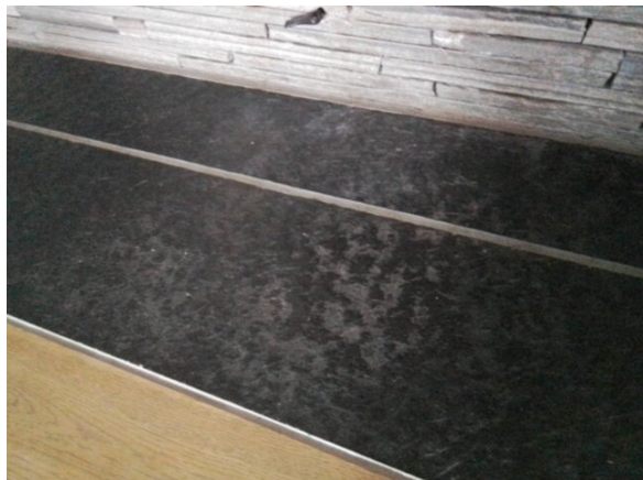
merke i skifer foran peis etter pipebrann
