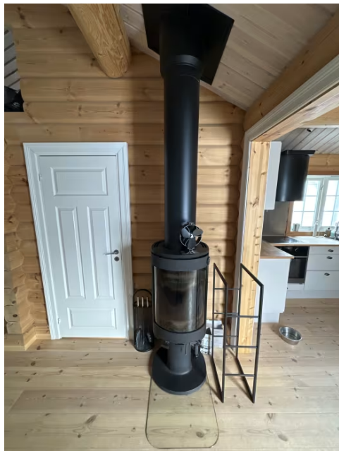
Viser ildsted montert i stue
