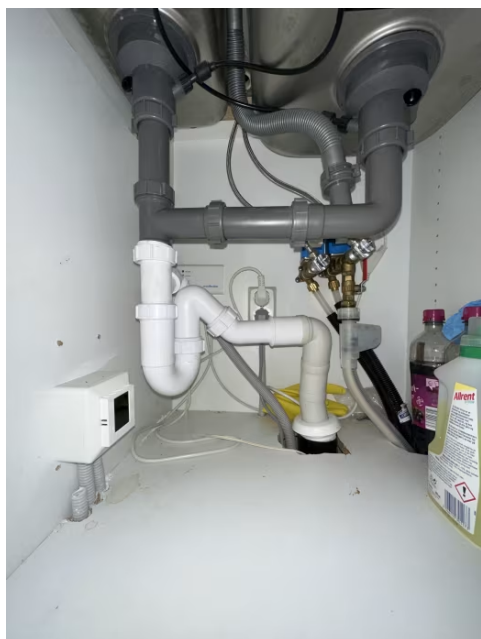
Viser vann og avløpsinstallasjoner under kum.
