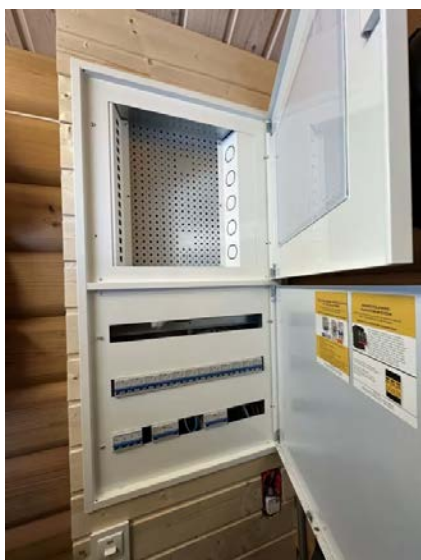
Viser sikringsboks plassert i bod. Avdekking, kursfortegnelse og lokk på koblingsboks blir utført før salg.
