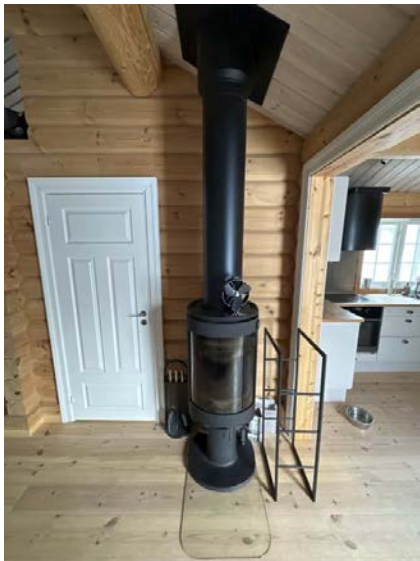
Viser ildsted monterert i stue
