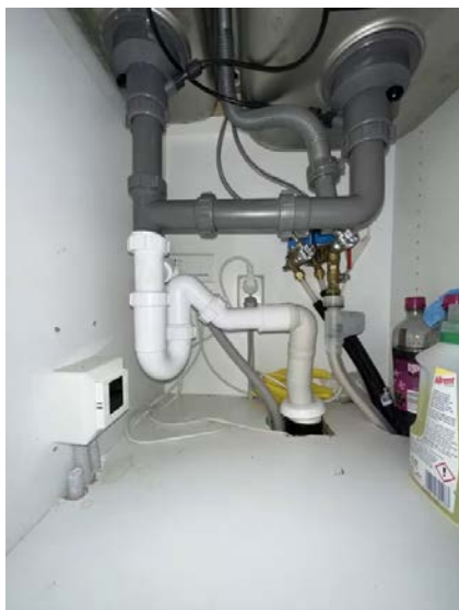
Viser vann og avløpsinnstallasjoner under kum.
