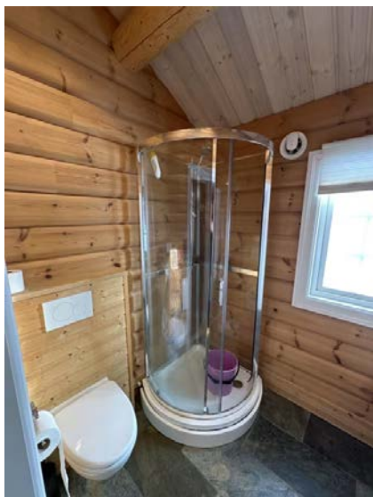
Viser toalett med innebygget sistene og dusjkabinett.
