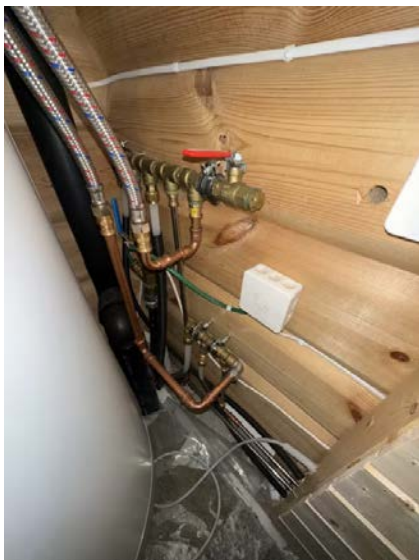
Vannrør med kobber og rør i rør system fra åpen fordeler plassert i bod og frem til sanitærinstallasjoner på baderom og kjøkken.
