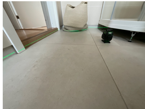
Gulvoverflaten på baderommet
