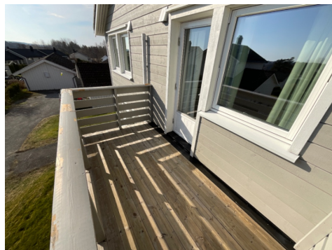
Balkong i andre etasje
