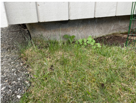
Grunnmur på hjørnet ved kjøkkenet
