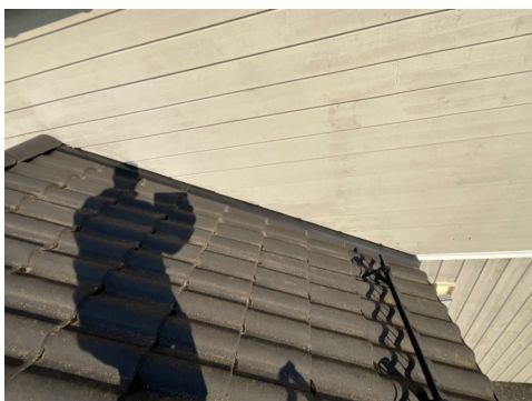
Utvendig trepanel mot beslag
