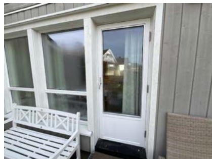
Terrassedør i stuen
