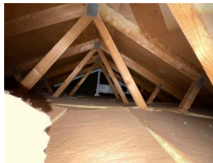
Loft over bodene i 1. etasje
