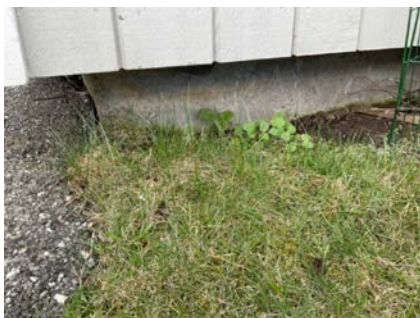
Grunnmur på hjørnet ved kjøkkenet
