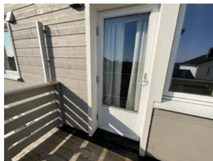
Balkongdør i 2. etasje
