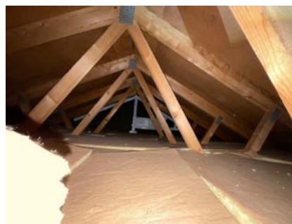
Loft over bodene i 1. etasje
