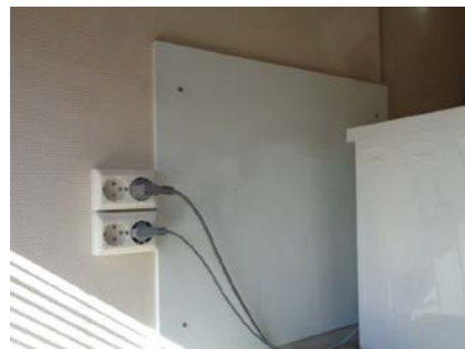
Rør i rør sentral på vaskerom.
