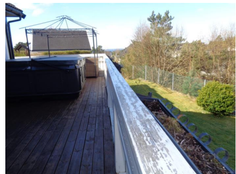
Skade på tredekke.
