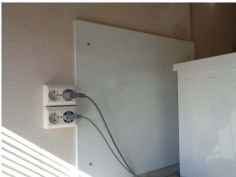
Rør i rør sentral på vaskerom.
