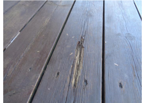
Skade på tredekke.
