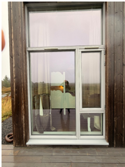
Bildet viser vinduer som er på fritidsboligen
