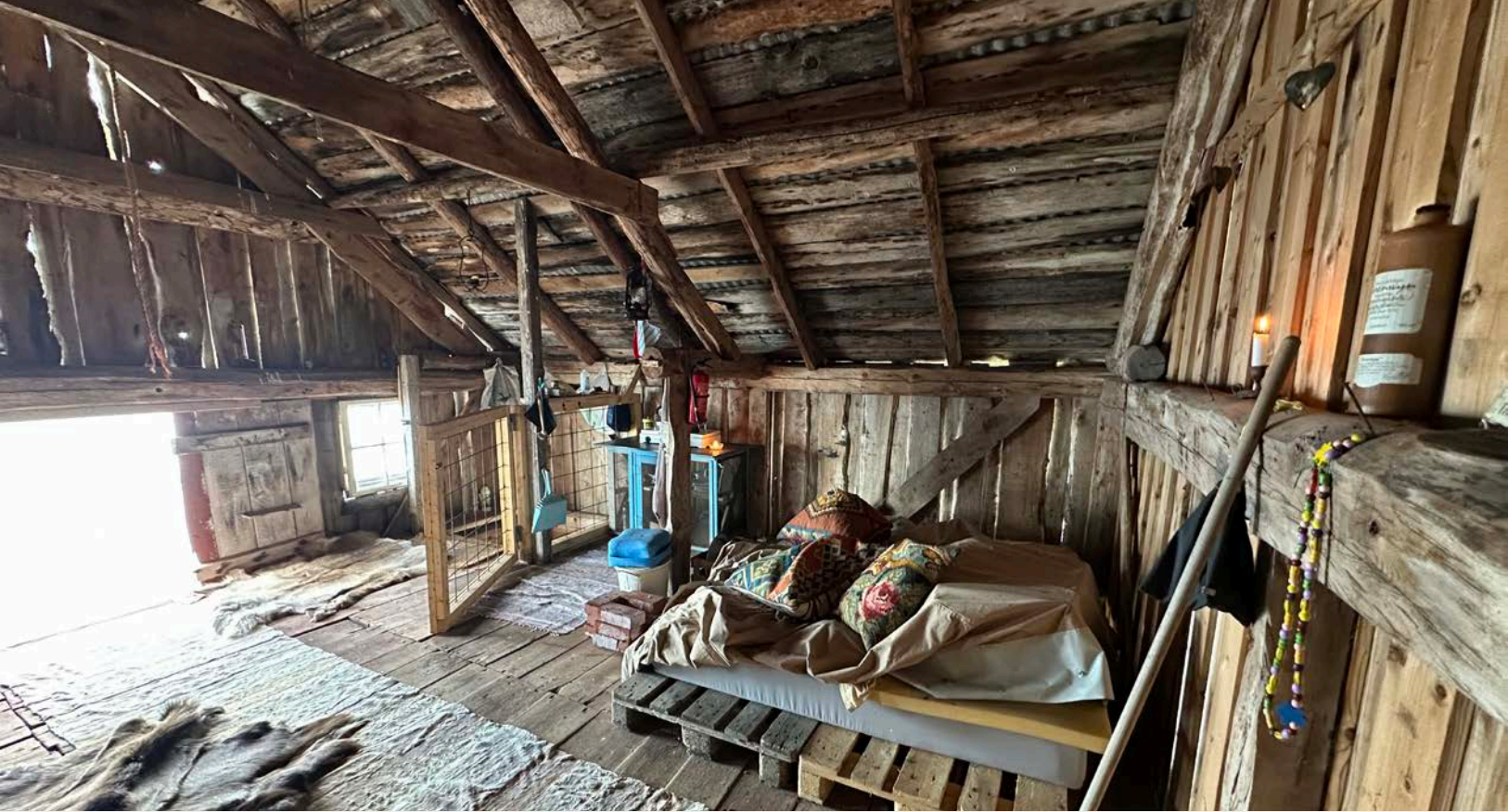
Selgers bilde fra innside av naustloft
