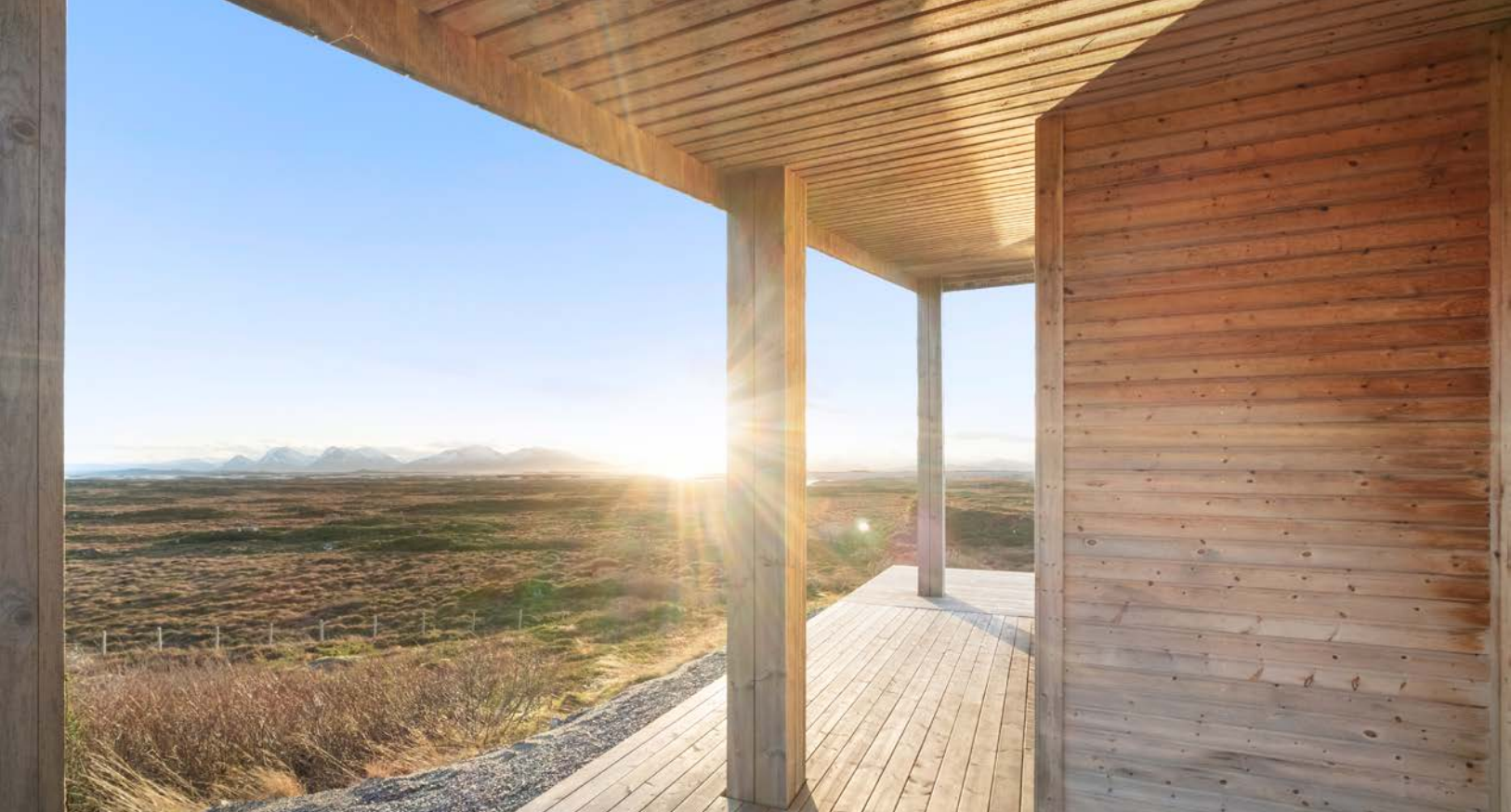
Markterrassen strekker seg rundt både sør- og østsiden av hytten.
