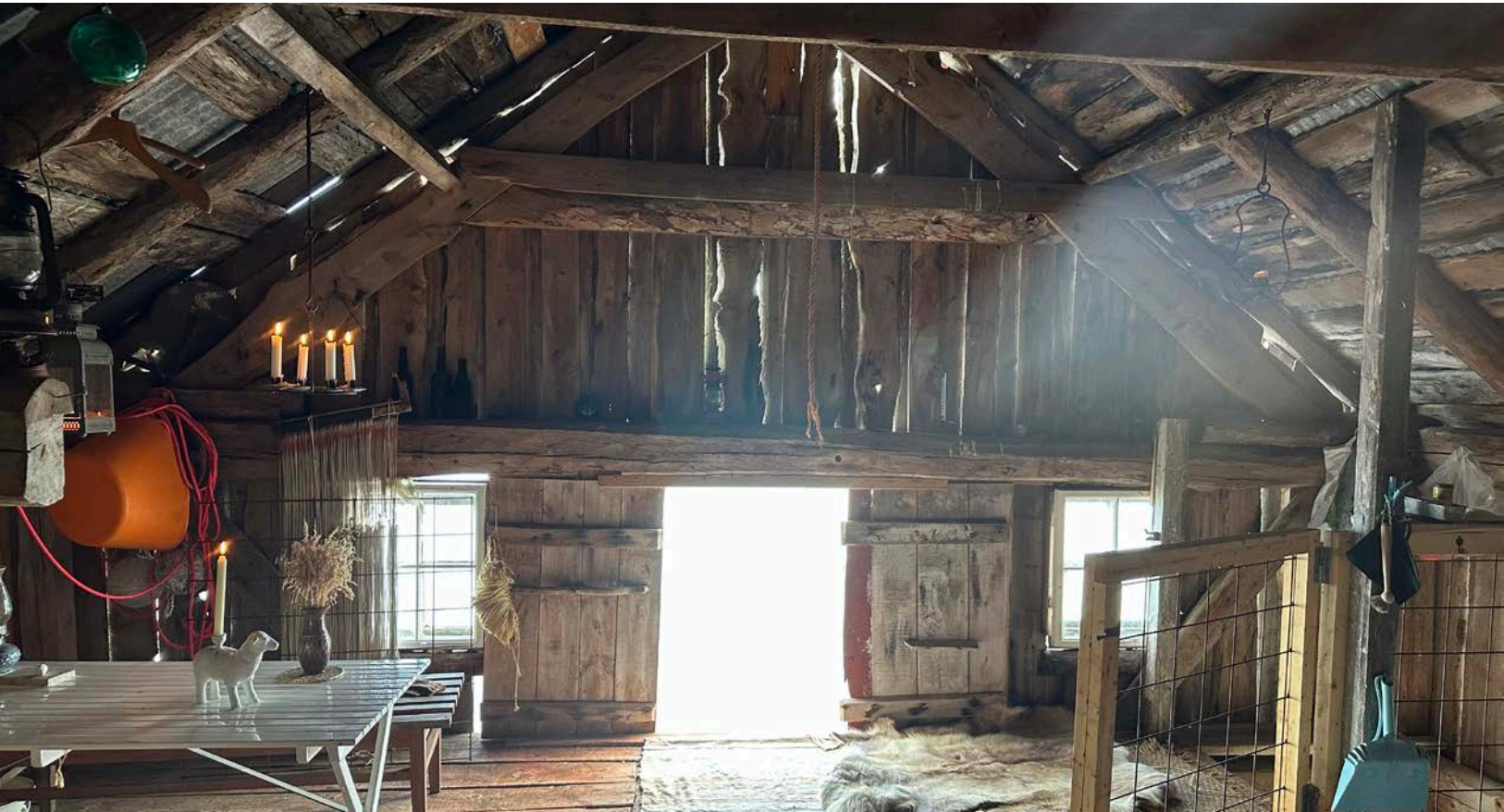
Selgers bilde fra innside av naustloft
