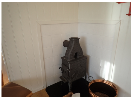
Innkledd pipe i 1. etasje
