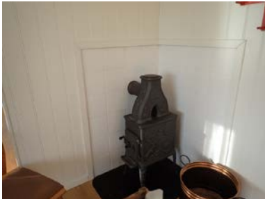
Innkledd pipe i 1. etasje
