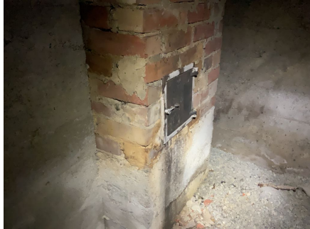
Sotluke plassert i kjeller.
