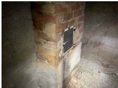
Sotluke plassert i kjeller.
